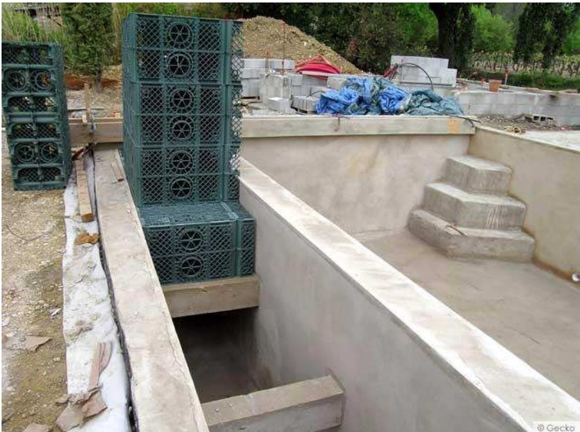
Pour l'escalier, afin qu'il ne prenne pas trop de place, le choix s'est porté sur **un escalier d'angle avec différentes hauteurs de marche** permettant de s'asseoir.
