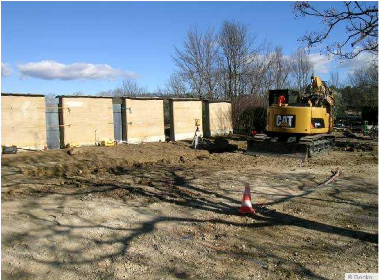
Pour la structure, suite à une étude en amont qui a révélé que **le terrain était argileux**, le constructeur a opté pour **une structure en banches**, pour un ouvrage en béton très résistant.
